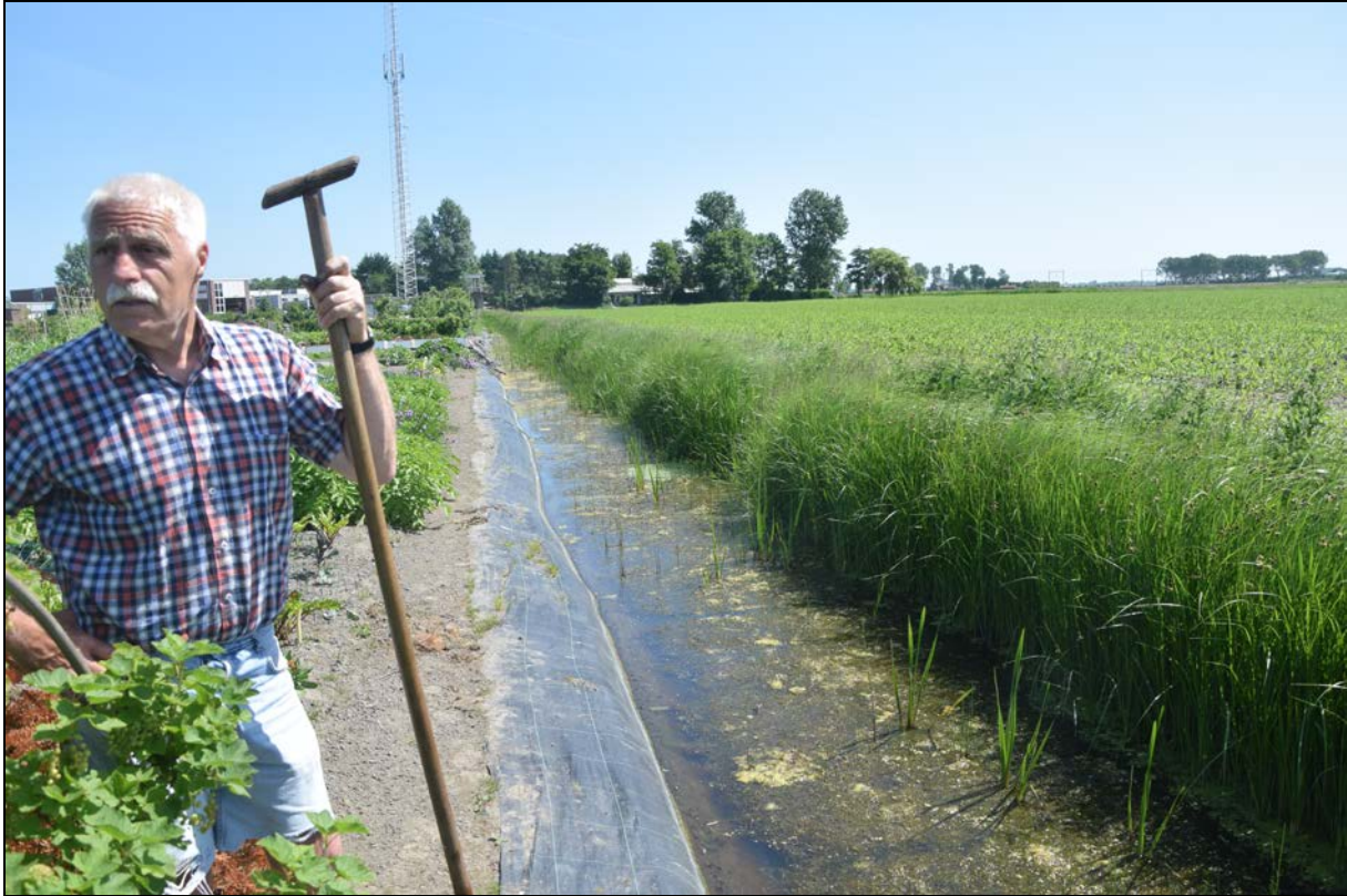
Kunststofbeschoeiing langs binnenduinrandwater
